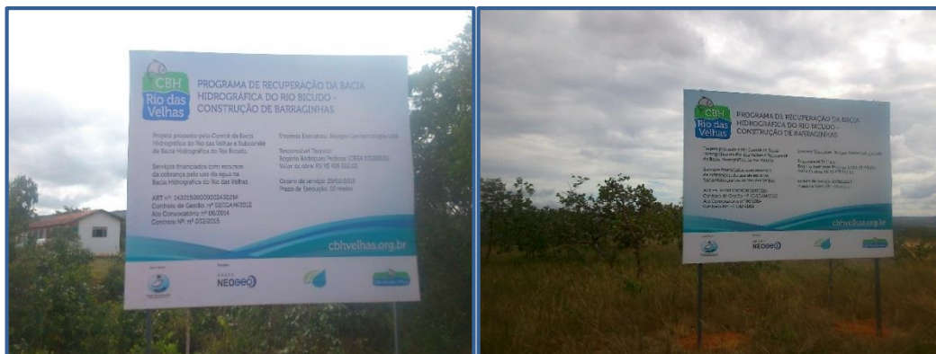
Figura 8: Retirada das Placas de Obra;
