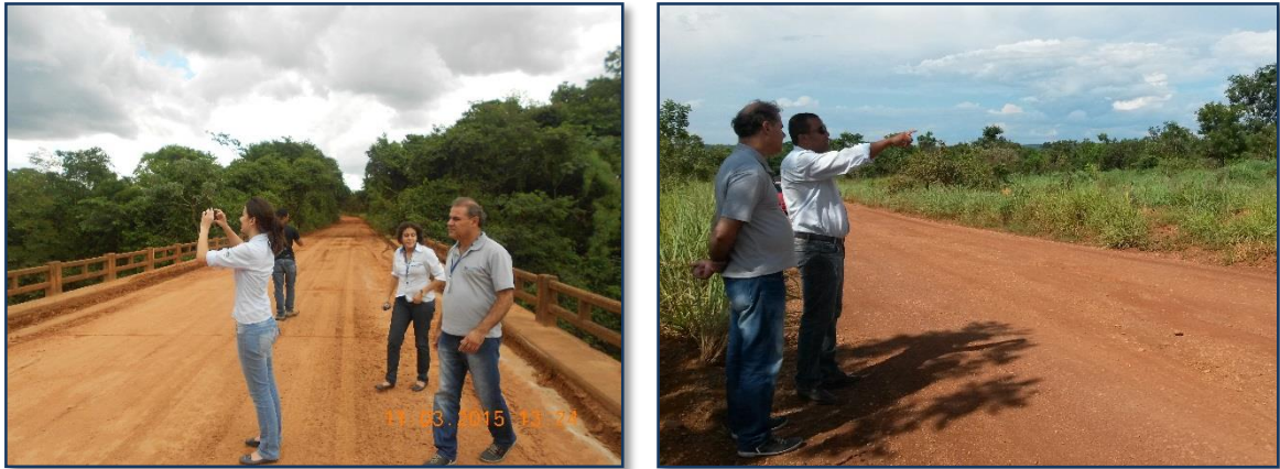
Figura 2: Supervisão dos serviços.
