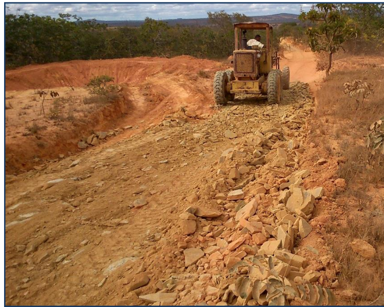
Figura 6: Cascalhamento das estradas;
